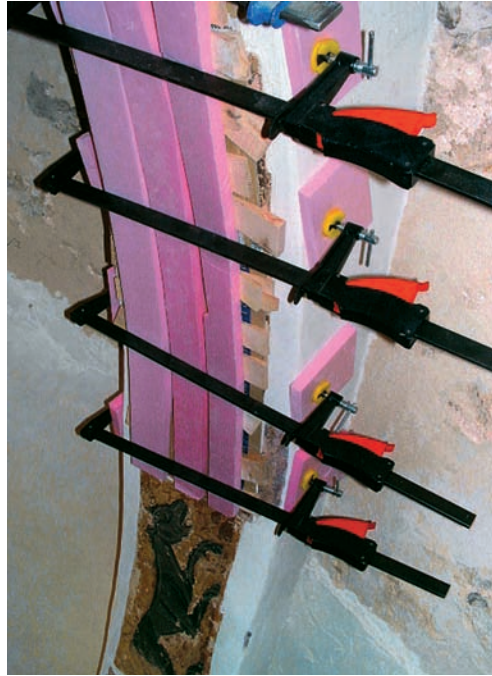
Figura 14. Proceso de adhesión en los nervios: a) preparación de la base con mortero de nivelación y b) sujeción con gatos de los fragmentos adheridos (fotos Coresal).
