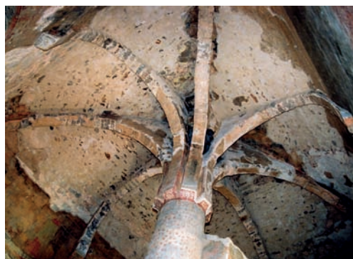
Figura 8. Consolidación del intradós, en 2001 y la bóveda tras la reubicación de las pinturas, en 2002.
