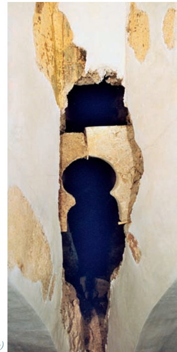
Figura 15. Proceso de reconstrucción de un arquillo: a) aplicación del mortero de nivelación; b) reconstrucción del arquillo con toba calcárea; y c) reubicación de fragmentos (fotos Coresal).
