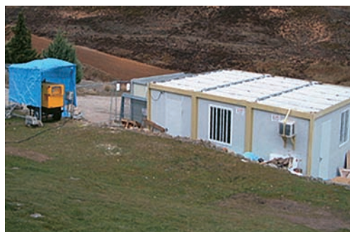
Figura 9. Trabajos in situ: Instalación de las casetas de obra y preparación de los fragmentos antes de su reubicación (fotos Coresal, 2001).
