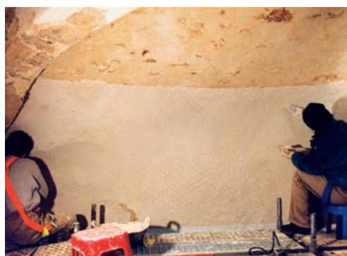
Figura 12. Aplicación y rallado del mortero de nivelación (foto Coresal, 2001).
